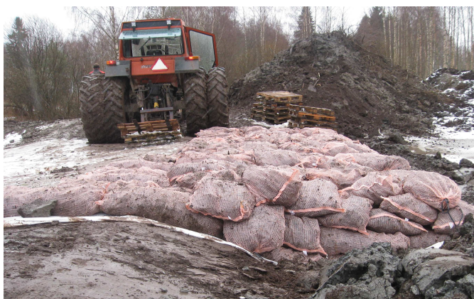
Säkitetyn rengasrouheen asentaminen vettä läpäiseväksi penkereeksi maatalouden kosteikkorakenteeseen 2014. Kuva: Apila Group Oy
