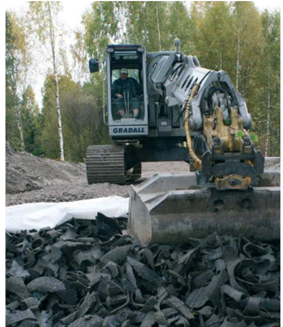
Rengasrouhe tulee erottaa maa-aineksesta geotekstiilillä, jotta materiaalikerrokset eivät sekoitu keskenään. Rouhetta kannatta käsitellä tela-alustaisella koneistolla. Kuva: Suomen Rengaskierrätys Oy
