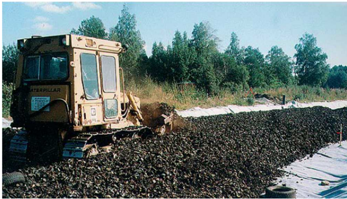
Tulvivan ja routivan lola-Sannainen tieosuuden korottaminen 1997. Kohteessa käytettiin 1900 tonnia rengasrouhetta. Kuva: Suomen Rengaskierrätys Oy.
