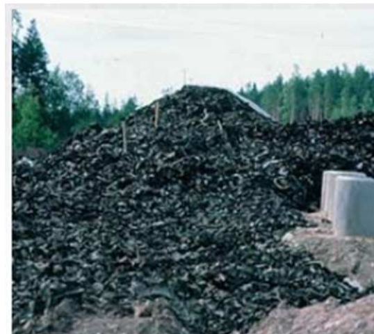
Materiaalina rengasrouhe on helppo käsiteltävä. Se voidaan tuoda paikalle kuorma-autoilla ja rakenne on muotoiltavissa kaivinkoneilla. Kuva: Suomen Rengaskierrätys Oy
